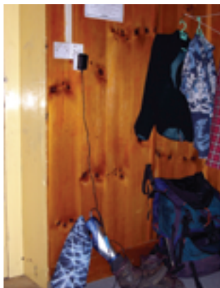
Ladestation: Im Hillary-Zimmer findet sich eine Steckdose
